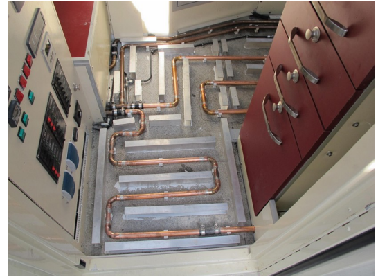
Fußbodenheizung
